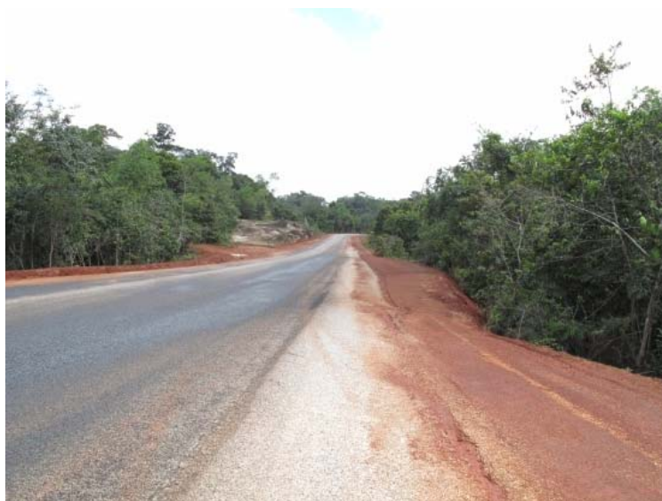
Illustration 10: Travaux de réfection de la RN2 (A. Thonnell, mai 2010)
